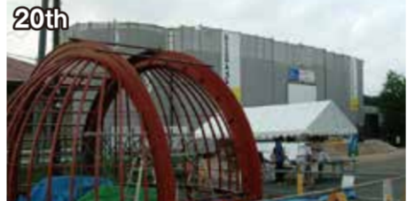
2003 20回開催は大型ドームの鉄骨が登場。いよいよ会場敷地内に天文台建設が開始されました。
